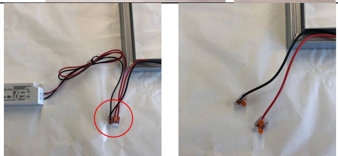
3 – IT) Collegare i fili di alimentazione e fissare la lampada a soffitto.
